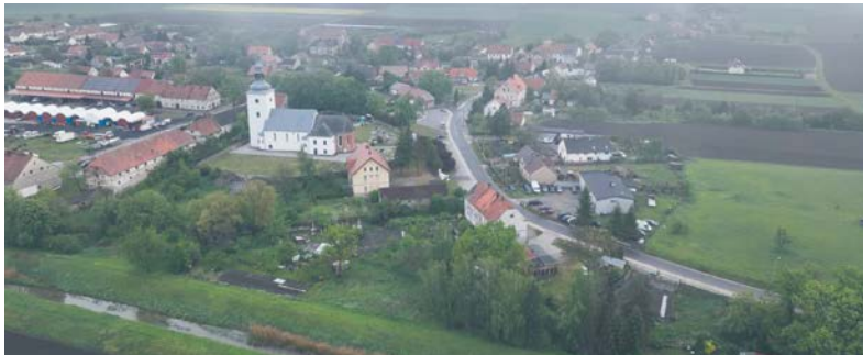
Tyńiec nad Ślężą, wieś zostanie wkrótce skanalizowana
