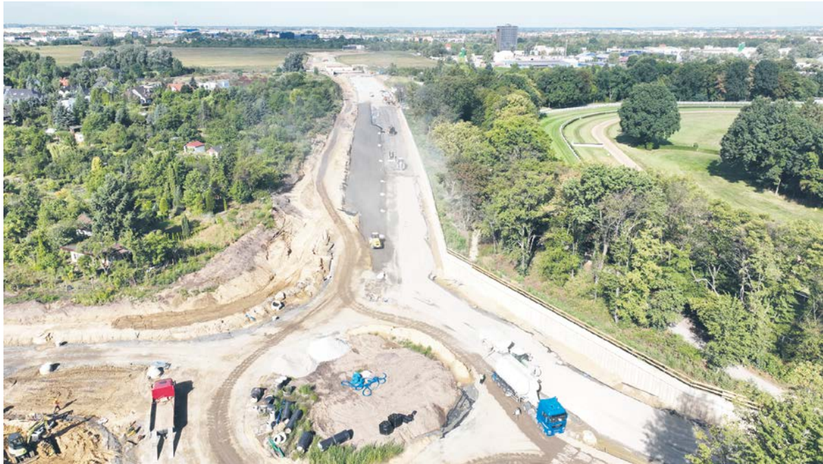
Budowa ronda na Wschodniej Obwodnicy Wrocławia w Wysokiej. Aktualny stan robót
